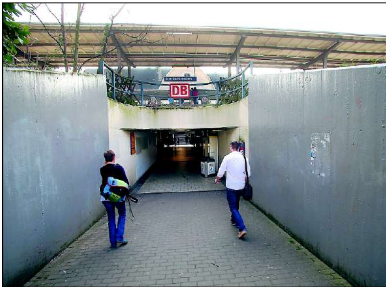
Zu steil, um den offiziellen Anforderungen der Barrierefreiheit zu genügen: Die Rampe hinter dem Bahnhof. FOTO: RONALD FRIESE
